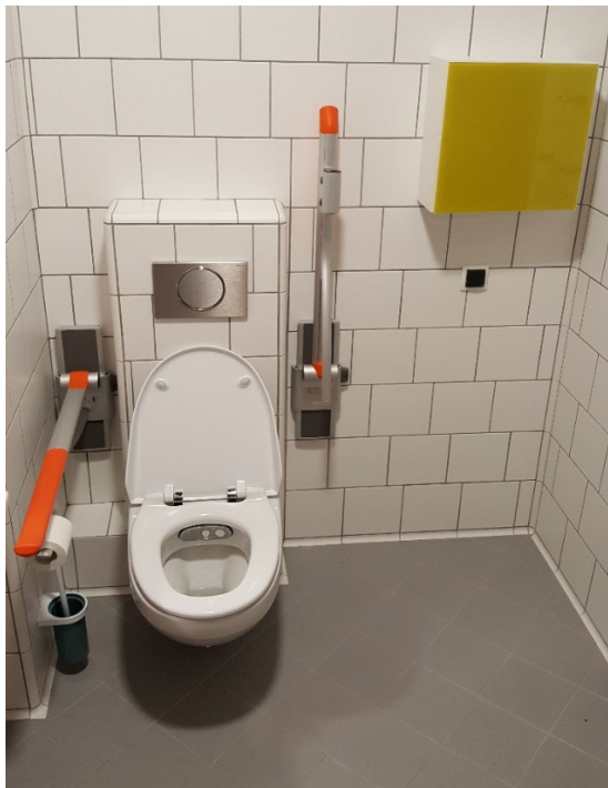
Fotografia 7 Toaleta z funkcją mycia. Zapewniona strefa przesiadania się z wózka i regulowane pochwyt.
